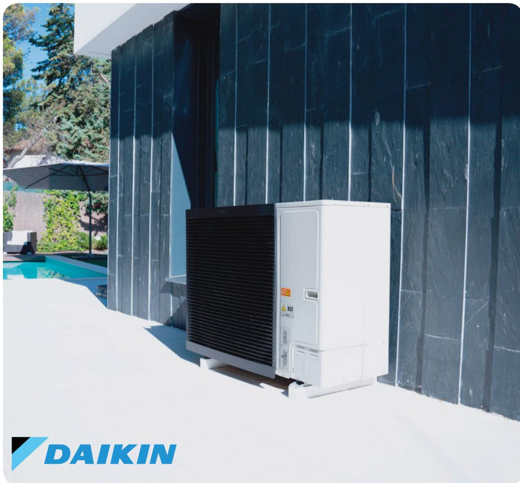
je do  $-25^{\circ}\text{C}$  vanjske temperature. Kao niskotemperaturna dizalica topline, posebno je učinkovita s niskotemperaturnim ogrijevnim tijelima, kao što su podno grijanje i konvektori dizalica topline, oboje su dostupni u potpunom Daikin rješenju.
