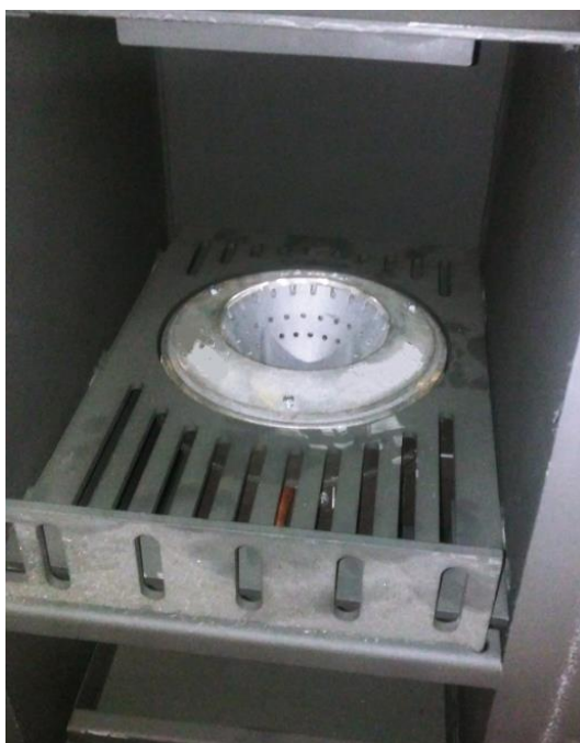
Prikaz čiste komore izgaranja kotla Pelling DUAL
