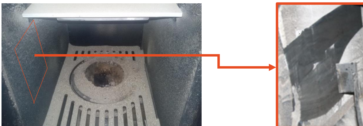
Prikaz čišćenja dijela prljave stijenke komore izgaranja
