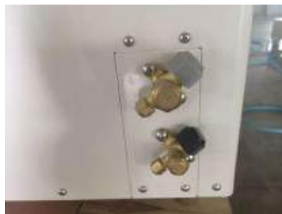
Priključak za freonske bakarne cijevi na unutrašnjoj jedinici
