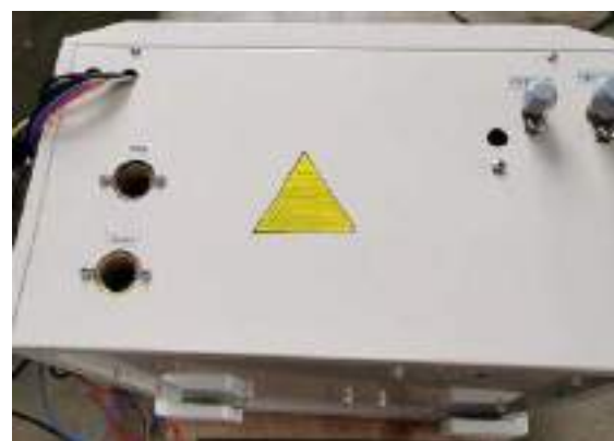
Priključak za freonske bakarne cijevi na unutrašnjoj jedinici
